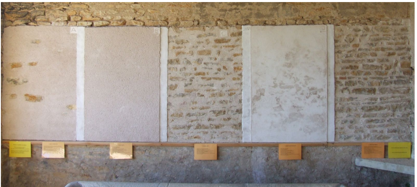
Ci- dessus présentation des différentes techniques d'enduit traditionnels réalisé à la chaux par des artisans du patrimoine. Lavoir de Saint Clément sur Guye (71)
